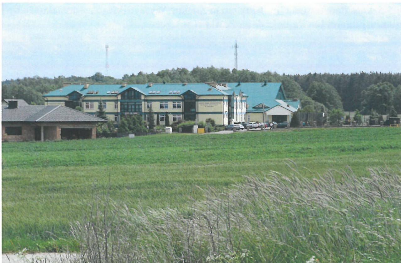
Budynek Szkoły Podstawowej w Czerwinie przy ulicy Piastowskiej
